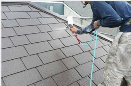
光触媒のセルフクリーニングによる防汚の他、UVカット効果で日焼けによる外壁の変色を防いだり、雨だれや藻の抑止効果があります。
